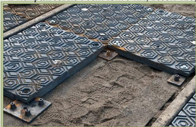
Чугунный переезд выгодно отличается от других сооружений аналогичного назначения. Под действием высоких или низких температур не деформируется, в отличие, например, от
