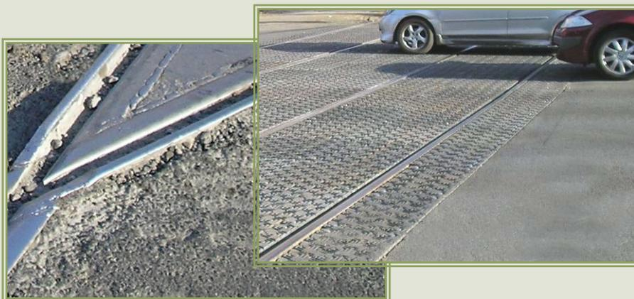
Плиты, имеют высокую точность размеров и формы, что позволяет укладывать полотно с минимально допустимыми зазорами от рельсов.
